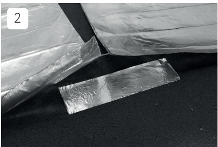
Einen ersten Aluminiumfolien-Klebestreifen an der Wendestelle auf die zuvor installierte Trittschalldämmung kleben.
