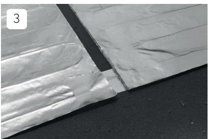
Den Klebestreifen so positionieren, **dass beide Mattenteile Kontakt mit dem Aluminiumfolien-Klebestreifen haben (!).**
