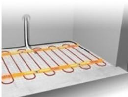
Boden und Wand müssen vor der Verlegung der Heizmatte für Kaltleiter und Temperaturfühler so aufgeschlitzt werden, dass zwei Leerrohre darin bündig versenkt werden können (**Achtung! Kaltleiter und Bodentemperaturfühler nicht im gleichen Rohr verlegen!**). Für den elektronischen Thermostat (Platzierung) sollte an der ausgewählten Stelle eine handelsübliche Unterputzdose mit 230 VAC Netzanschlussleitung aus dem Hausnetz vorhanden sein. Ein Fehlerstromschutzschalter (30 mA) ist vorzusehen.
